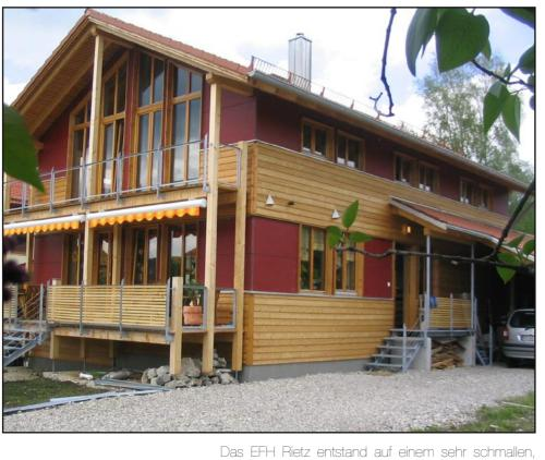
langgestreckten Grundstück. Da das Haus im Hochwasserbereich der Mangfall liegt, wurde das EG ca. 1,10 m über Gelände geplant. So schwebt das Ge-
